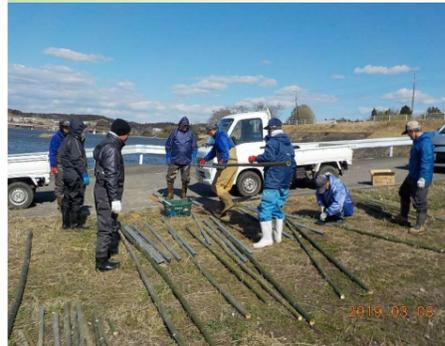
陸で網設置用の杭(鋼管+竹)作り
